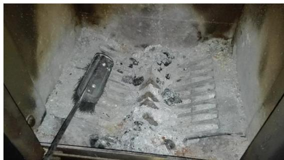
La pulizia della cenere è obbligatorio quando la seconda camera di combustione si riempie ad un`altezza di 3 cm.
