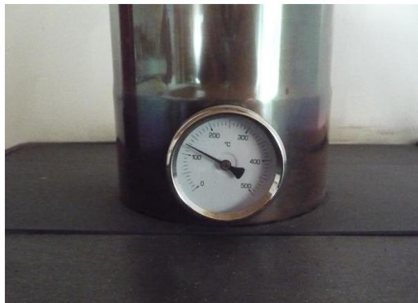
La temperatura alta riesce a riscaldare ed asciugare il camino dall'umidità. La temperatura bassa di 120° – 150 ° si viene a formare dopo questa procedura perchè la termostufa ed il camino (canna fumaria) sono ben temperati e si è formato tanta brace nella camera di combustione superiore. Dopo si chiude il registro fumi e da questo momento la temperatura dei fumi risulta essere bassa.
