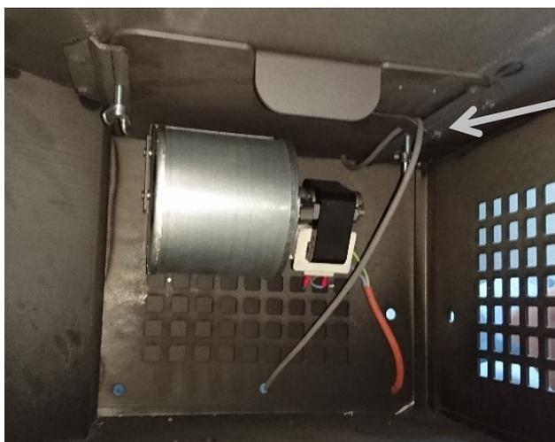
**Fissaggio cavo sonda**
