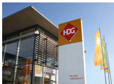
Completamento della struttura degli uffici amministrativi
